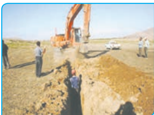
کندن زمین با بیل مکانیکی
